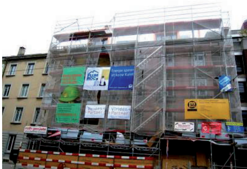
Gelungene Objekte des Gesamtsanierungsprogramms: Die Feldbergstr. 4 und 6.
