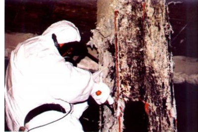
Asbestsanierung mit Schutzaus- rüstung
